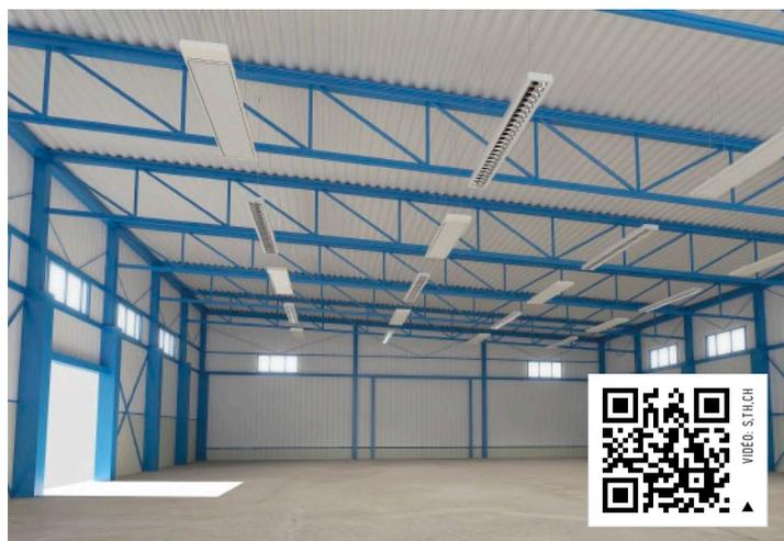
► **ECOSUN S+ / S+Anticor** – pour halles industrielles, gymnases, salles, ateliers etc. avec le milieu correspondant au recouvrement donné. Convenable aussi au dessèchement des bâtiments. A l'intention des lieux avec une humidité élevée tels que exploitations agricoles ou stations de lavage, les panneaux sont fournis en version inox S+Anticor.
